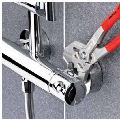
Práce s chromovanými armaturami bez poškození povrchu
