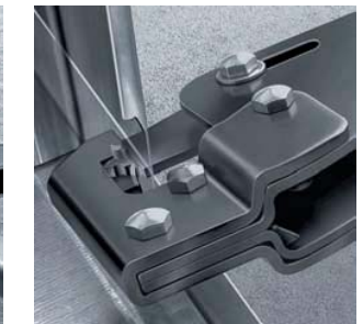
Das Stempelwerkzeug wird durch die Profilbleche gedrückt
